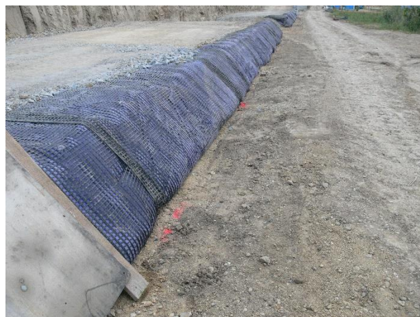
Obr. 50. Správně dopnutý líc balené zeminy
