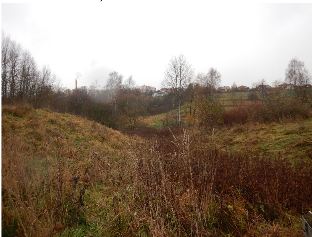
FOTO2: Pohled na dolní část sesuvného území
