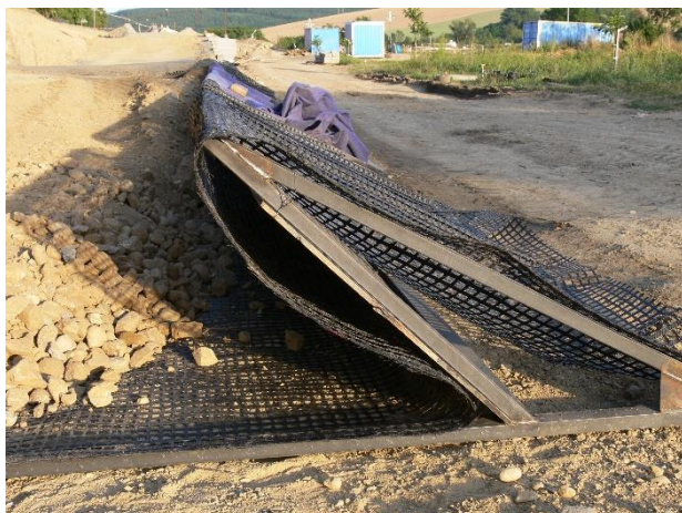
Obr. 47. Posuvné bednění, pohled z boku
