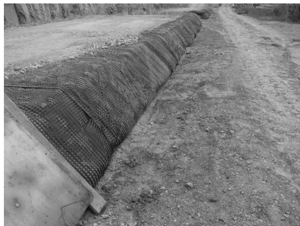
Obr. 50. Správně dopnutý líc balené zeminy
