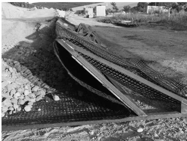
Obr. 47. Posuvné bednění, pohled z boku
