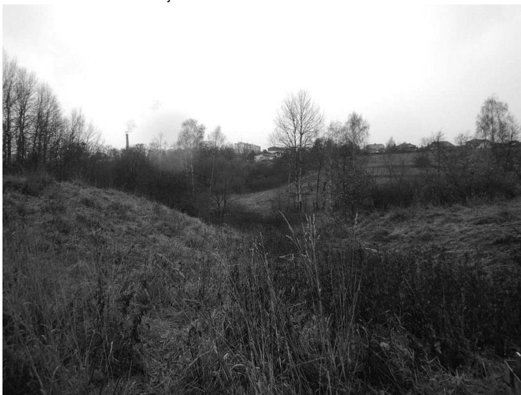
FOTO2: Pohled na dolní část sesuvného území
