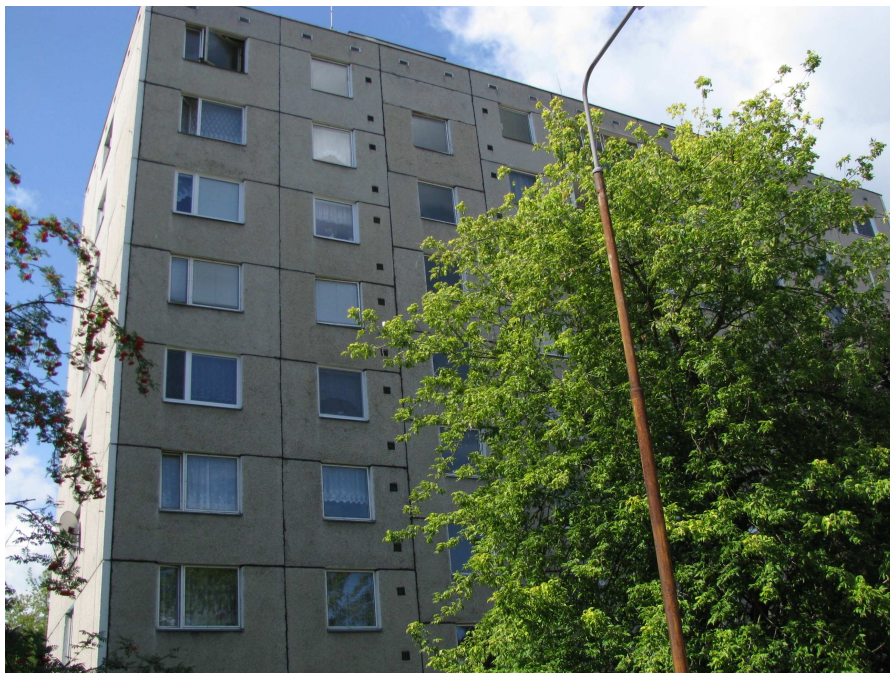
Bytový dům Jilemnického 74, Ústí nad Orlicí
