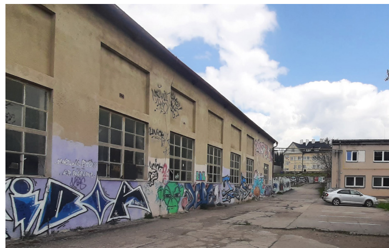
stávající průmyslová stavba
