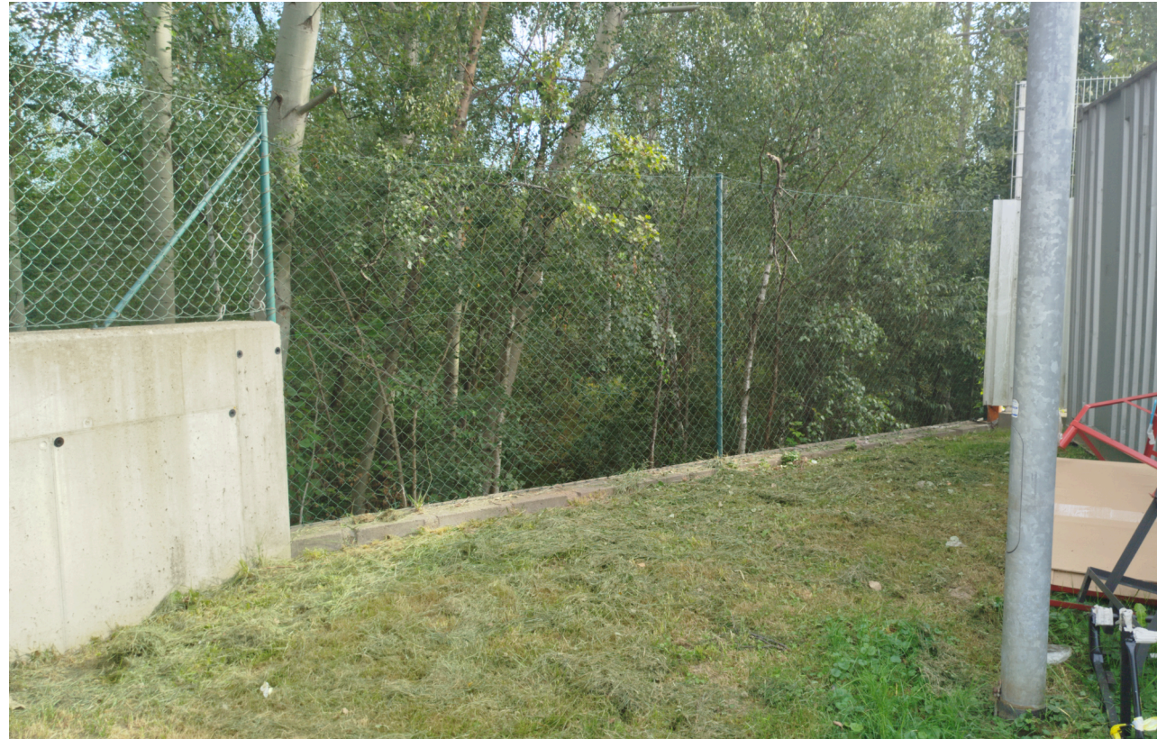
Terén lokality je oproti komerčním objektům snížěn o několik metrů, což je řešeno opěrnou zdí.
