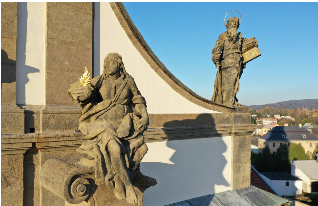
Kostel Nanebevzetí Panny Marie – opravené sochy v průčelí
